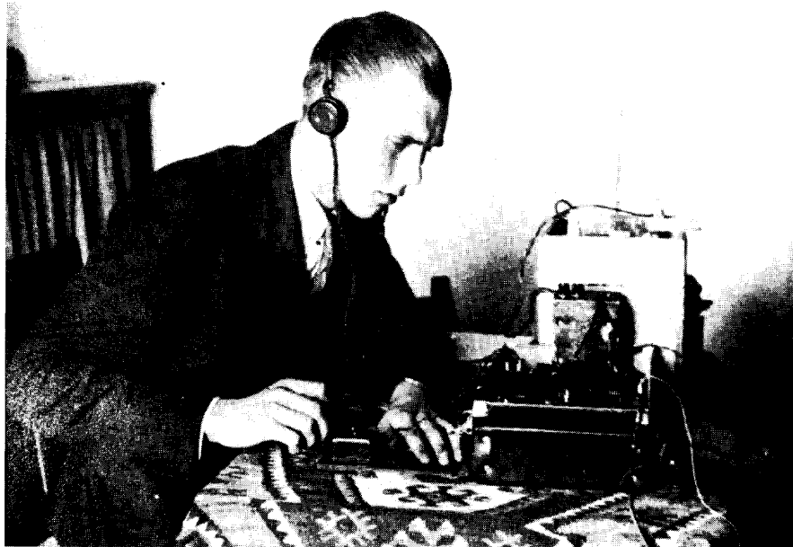
Fig. 15. Deze in april 1945 gemaakte foto toont BBO-agent Wouter Pleysier in actie met een A Mark III vanuit het huis van de familie Verkade te Zaandam. Achter de radio de trillervormer en de accu. (foto beschikbaar gesteld door Eddy de Roever, auteur van 'Zij sprongen bij maanlicht').
